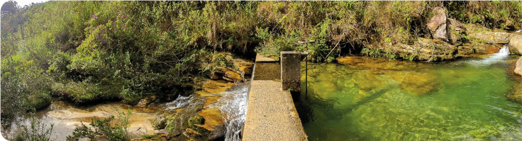
Captação Itacolomi – Saneouro, Ouro Preto (MG)
