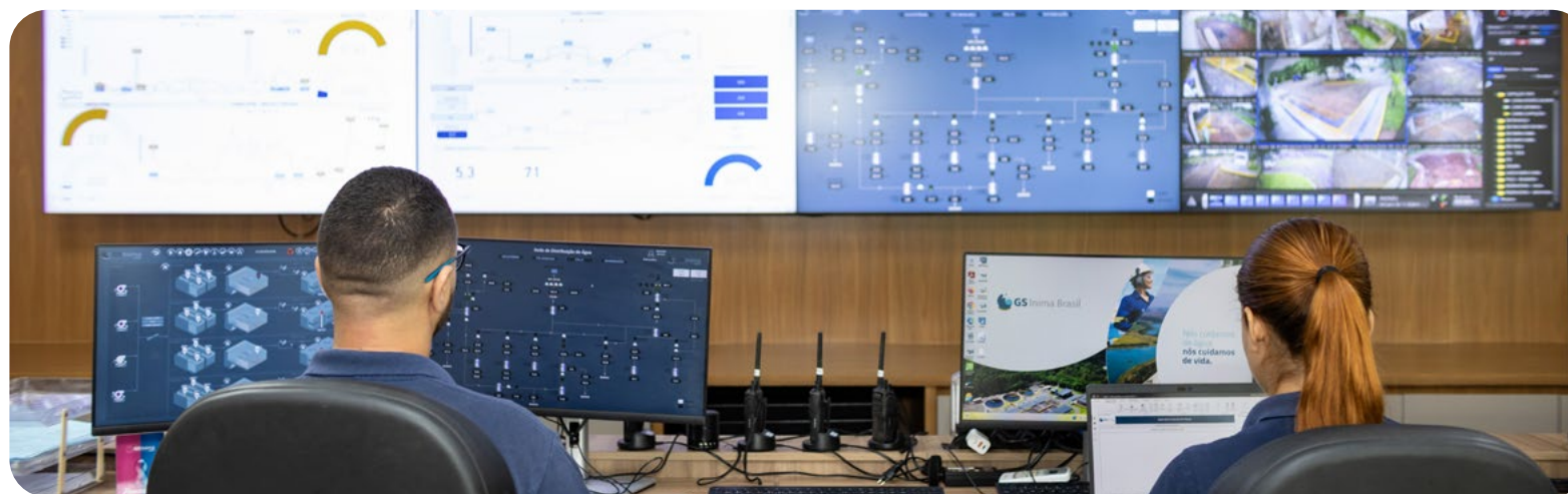
Centro de Controle Operacional da GS Inima Samar, em Araçatuba (SP).
